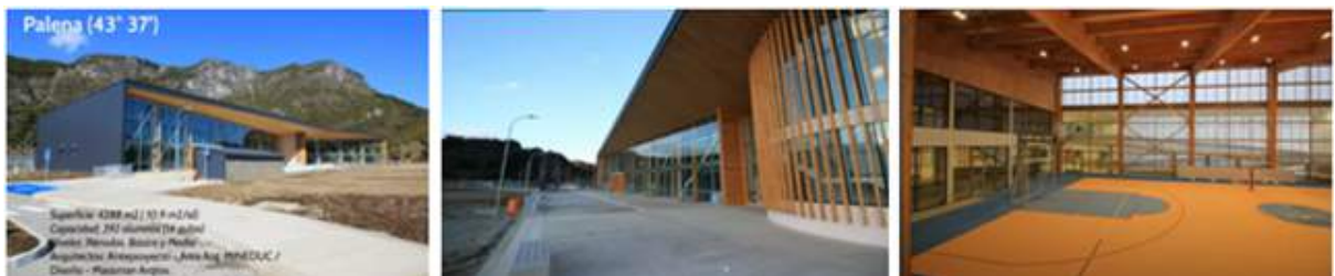
Figura 57- Escuela Roberto White, Palena. Estructura mixta, acero- madera con un muro invernadero en la fachada norte que permite precalentar el aire con recuperadores de calor en la cubierta. Fuente: Plataforma Arquitectura.
