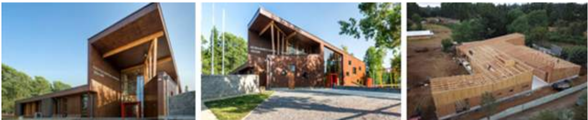
Figura 56- Proyecto detonante. Escuela rural Cantino, Vilcún. Construcción industrializada CADWORK, integra procesos de diseño, prefabricación, estandarización y digitalización. Fuente: Plataforma Arquitectura.
